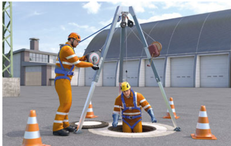
Abbildung 11-6: Rettung aus einem Schacht durch ein Höhensicherungsgerät mit integrierter Rettungshubeinrichtung und transportabler Anschlageneinrichtung (Dreibein)
