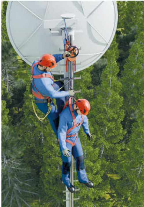
Abbildung 11-5: Rettung durch Abseilgerät mit integrierter Hubeinrichtung
