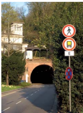
Abbildung 17: Tunnel, gekennzeichnet mit Tunnelkategorie „E“
