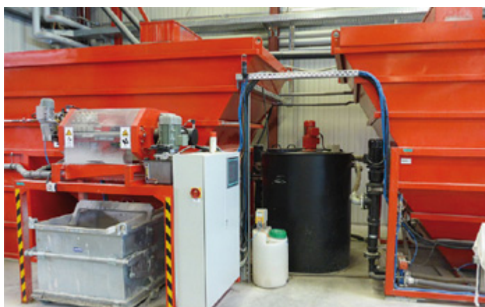
Abbildung 17: Wasserreinigungsbehälter mit nachgeschalteter Schlammpresse
