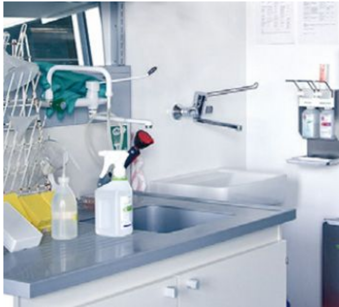
Abbildung 37: Aufkantung an Flächen, hier im Waschbeckenbereich
