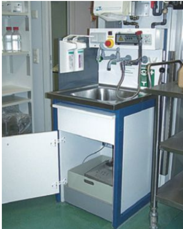
Abbildung 48: Handwaschbecken mit sterilisierbarem Auffangbehälter für Abwasser
