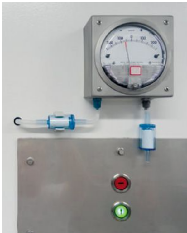
Abbildung 2: Analoganzeige für Raumunterdruck
