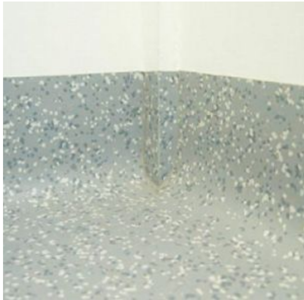
Abbildung 43: Naht- und fugenloser Übergang vom Bodenbelag zur Wand
