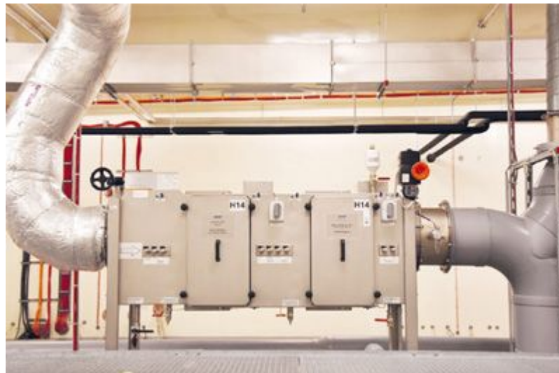
Abbildung 1: Raumluftechnik – Gehäuse für zwei in Serie geschaltete H14-HEPA-Filter
