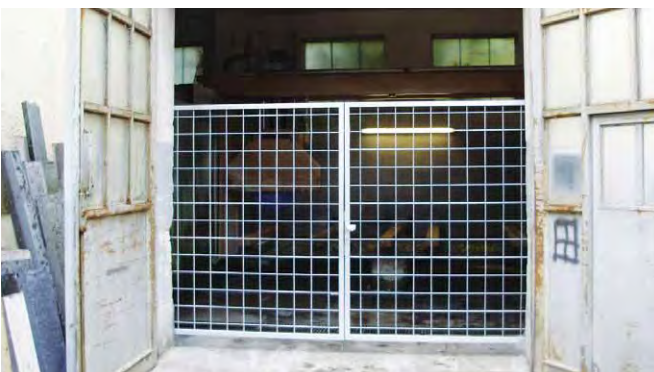
Abb. 11: Im Gebäude befindet sich nur eine Anlage
