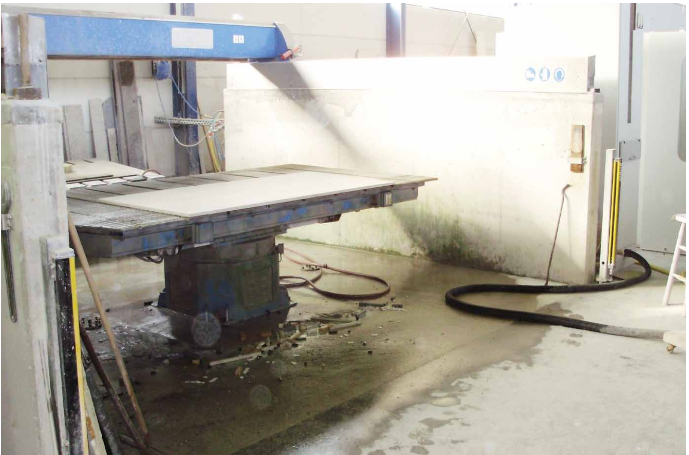
Abb. 10: Bereichssicherung durch eine Lichtschranke
