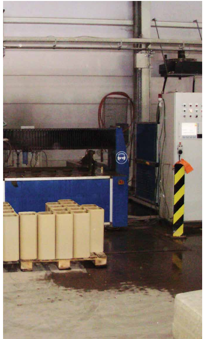
Abb. 9: Absicherung des Gefahrenbereiches durch eine Lichtschranke
