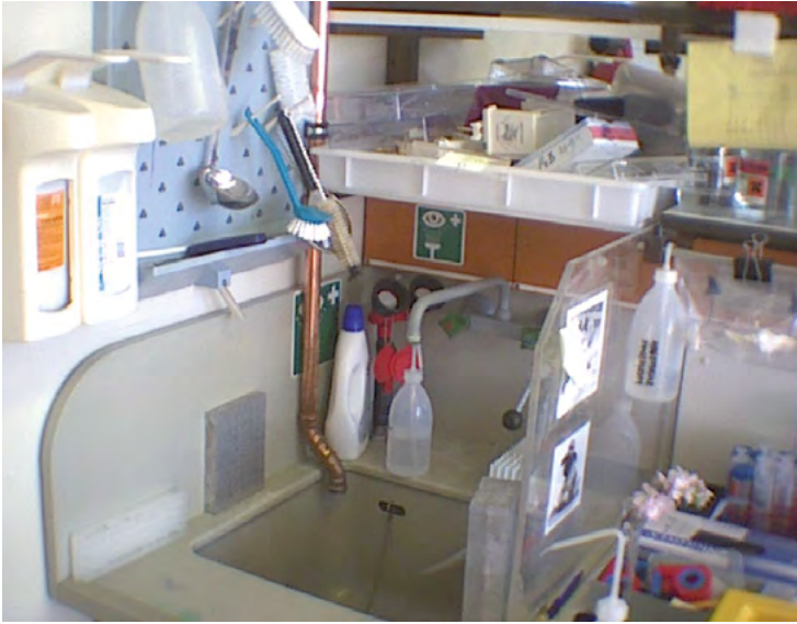
Abbildung 32: Negativbeispiel für eine blockierte Augennotdusche, die im Fall einer Verletzung dazu führt, dass für die Rettung des Auges wertvolle Sekunden ohne Hilfsmöglichkeit verstreichen.
