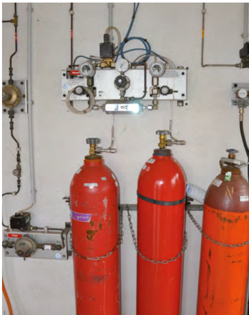
Abbildung 18: Druckgasflaschen mit (Acetylen, rechts) und ohne (Wasserstoff, links) Kennzeichnung „N“
