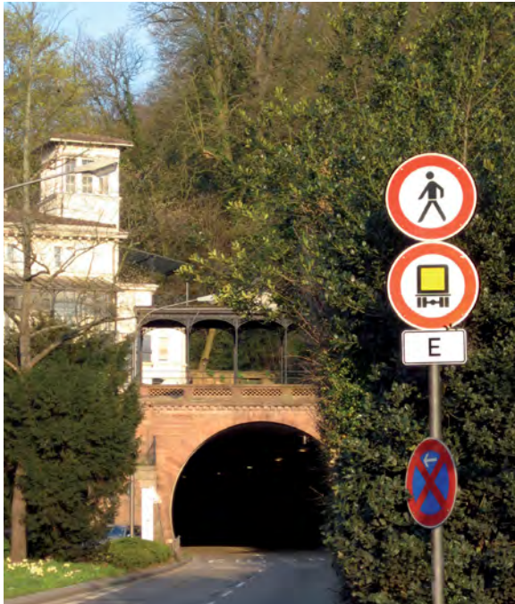
Abbildung 17: Tunnel, gekennzeichnet mit Tunnelkategorie „E“
