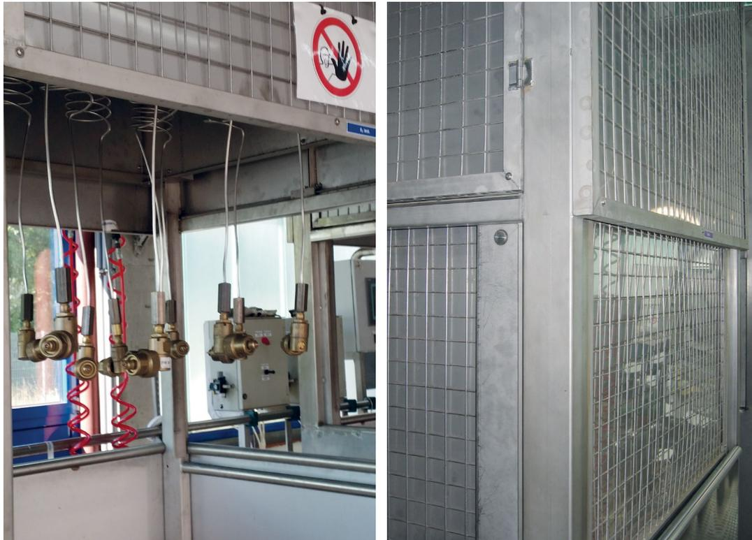
Abbildung 1: Abschirmung eines Füllstandes (links offen, rechts geschlossen)
