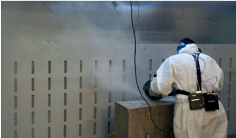
Abbildung 13: Steinschneiden an einer Absaugwand
