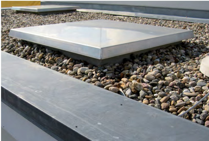
Abbildung 3: Druckentlastungsfläche im Dach der Lagerbox von außen gesehen
