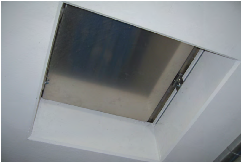
Abbildung 4: Druckentlastungsfläche im Dach der Lagerbox von innen gesehen
