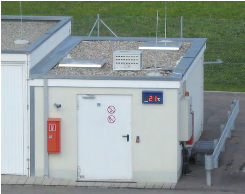
Abbildung 1: Klimatisierte Peroxid-Lagerbox für 4 500 kg Organische Peroxide der Gefahrgruppe OP Ib mit Blitzschutz und Anfahrerschutz
