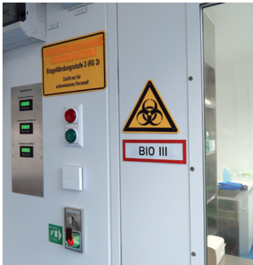
Abbildung 30: Foto einer Schleuse mit Zugangskontrolleinrichtung und Kennzeichnung als Schutzstu- fenbereich 3
