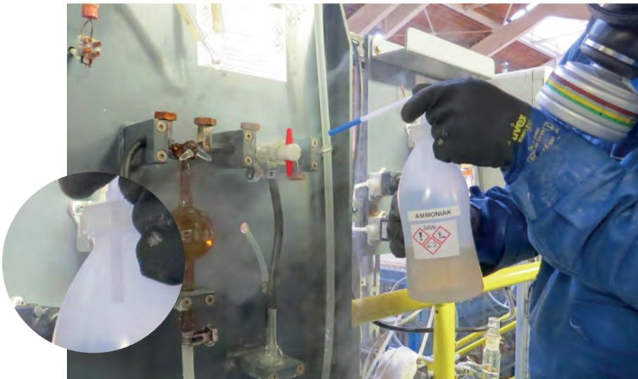
Abbildung 13: Lecksuche mit Ammoniak (Entnahme aus der Gasphase der Spritzflasche)
