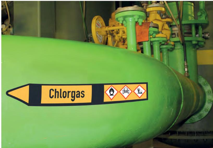
Abbildung 10: Kennzeichnung einer chlorführenden Rohrleitung
