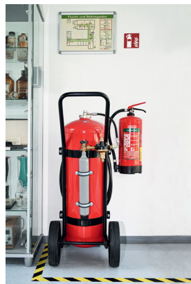
Abbildung 30: Gekennzeichnete Feuerlöscheinrichtungen
