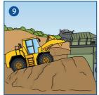
Fahrbahnen an Böschungen und Rampen gegen seitliches <u>Überfa</u>hren absichern.
