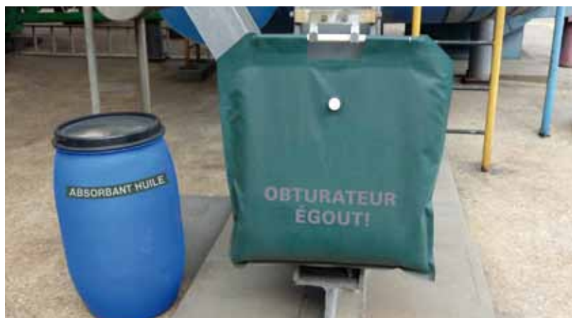
Produit absorbant et obturateur de bouche d'égout
