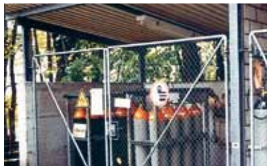
L'accès à l'aire de stockage est interdit aux personnes non habilitées
