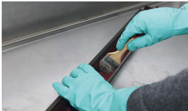
Vorsorgeanlass Feuchtarbeit (Verwendung flüssigkeitsdichter Handschuhe)
