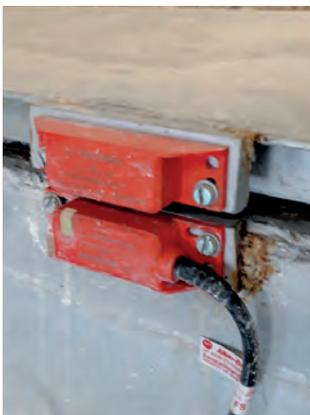
Abbildung 5: Berührungslos wirkender Bauart 4 Positionsschalter
