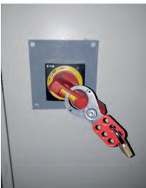
Abbildung 12: Hauptschalter mit Mehrfachschließbügel
