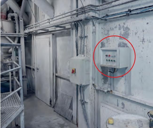
Abbildung 6: Vor-Ort-Steuerung mit freiem Blick auf die gefährbringende Bewegung und entsprechendem Abstand zur Gefahrstelle
