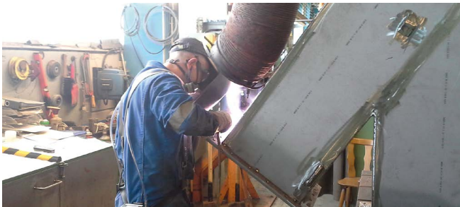
Abbildung 1: Beim Schweißen entstehende Schweißrauche können krebserzeugende Metallstäube und deren Verbindungen enthalten.
