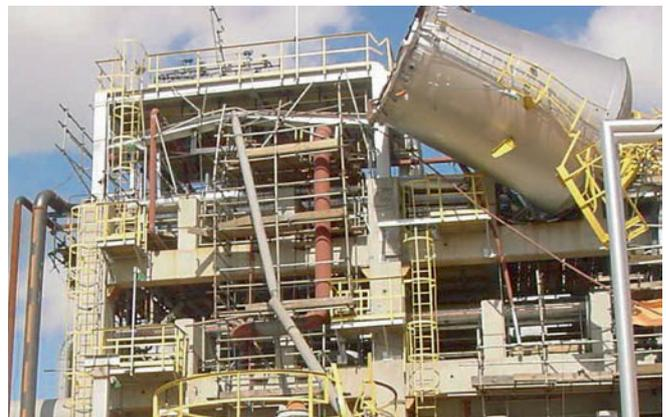
Abbildung 1: Abheben eines Tanks infolge Überdrucks
