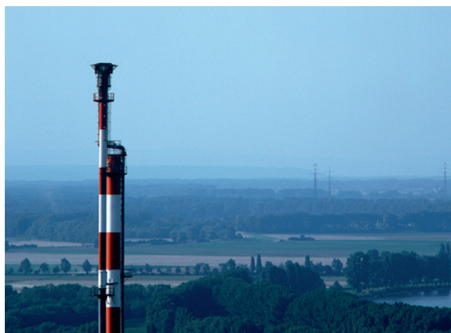
Abbildung 2: Fackeln dienen der gefahrlosen Ableitung von Stoffen
