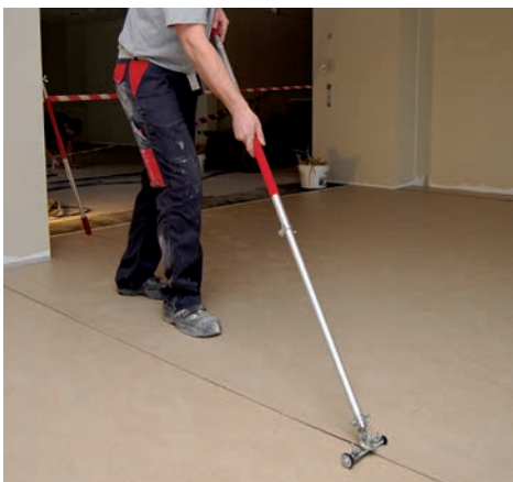
Anreißen des Belags im Stehen.
