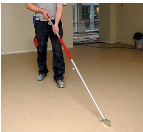
Mit dem Fugenschneider wird die Bahn geschnitten.
