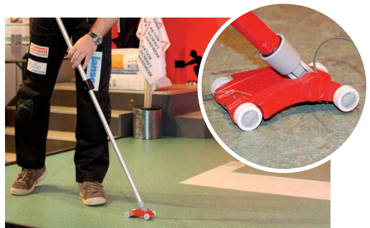
Der „Speed-Trimmer“ beim Abstoßen im Einsatz (zwei Arbeitsschritte können jetzt zusammen im Stehen erfolgen)
