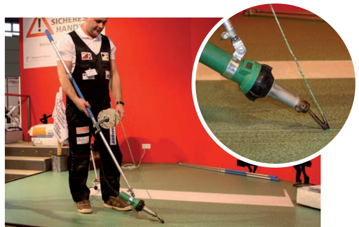
Das Verschweißen der gefrästen Fuge kann auch im Stehen erfolgen.
