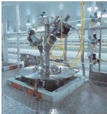
Abbildung 5: Flüssigkeitswiegesystem mit Entlüftung
