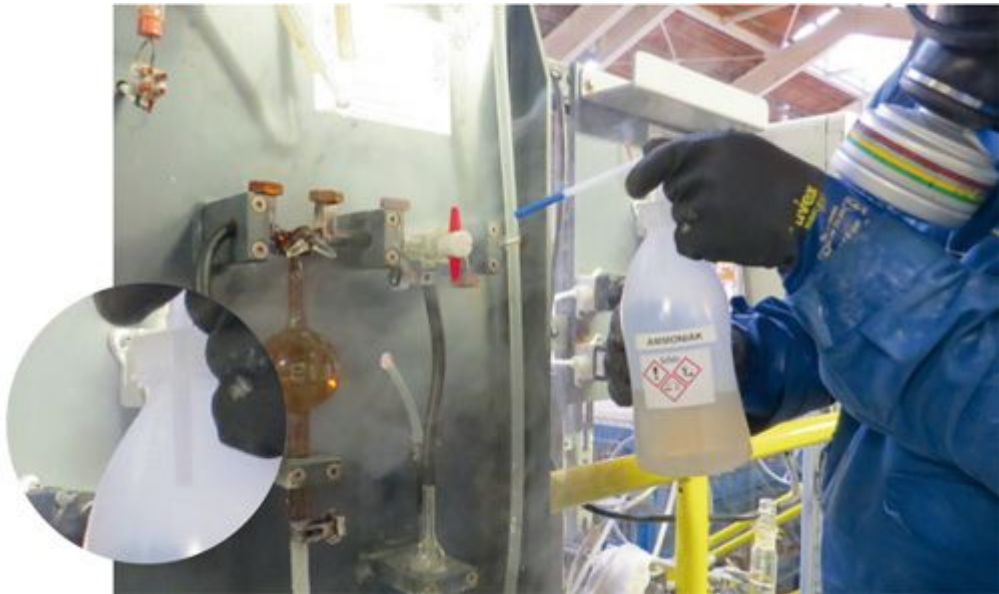
Abbildung 14: Lecksuche mit Ammoniak (Entnahme aus der Gasphase der Spritzflasche)
