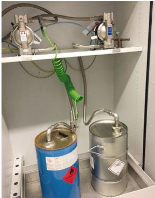
In bestimmten Fällen reicht die Verwendung einer geschlossenen Apparatur nicht aus, z. B. bei der Bitumenextraktion. Der Analysator muss entweder unter einem Abzug platziert sein, in einem Abzugschrank oder in einem separierten, belüfteten und begehbaren Raum mit Absaugung, der durch Glastüren o. Ä. einsehbar ist.
