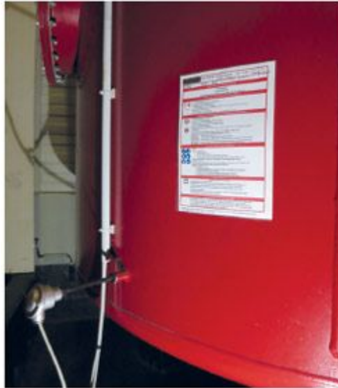
Abbildung 14: Betriebsanweisung an einem Isocyanat-Tank
