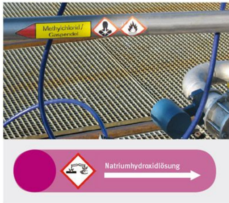
Abbildung 11: Innerbetriebliche Kennzeichnung von Rohrleitungen gemäß ASR A1.3 und TRGS 201 (15)
