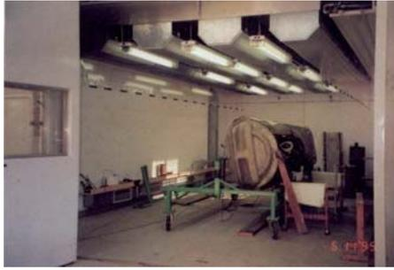
Die Zuluft wird 3–4 °C unterhalb der Raumtemperatur möglichst strömungsfrei in den Arbeitsbereich geleitet. Je nach Außentemperatur ist die Zuluft im Bedarfsfall durch die Kühlanlage zu behandeln. Durch die Kombination der gezielten laminaren Luftströmung und einer elektronischen Temperaturdifferenzregelung werden Styrolkonzentrationen  $< 20 \text{ mg/m}^3$  erreicht.
