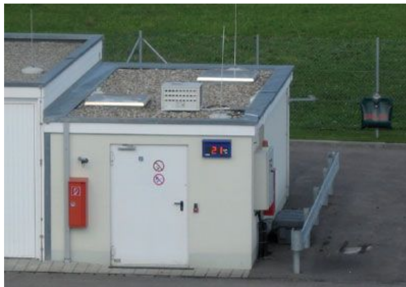
Abbildung 1: Klimatisierte Peroxid-Lagerbox für 4 500 kg Organische Peroxide der Gefahrgruppe OP Ib mit Blitzschutz und Anfahrerschutz
