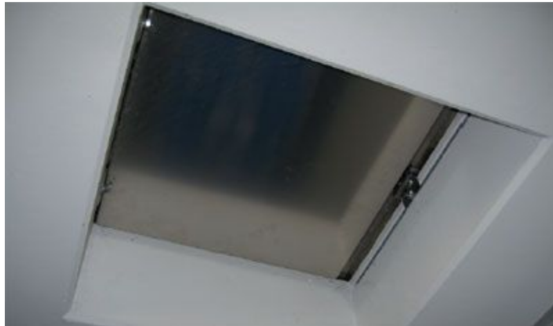
Abbildung 4: Druckentlastungsfläche im Dach der Lagerbox von innen gesehen
