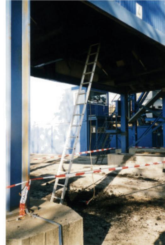
▲ Das ging schief, als seine nichtsahnenden Kollegen wegen Reparaturarbeiten den Hauptschalter ausschalteten. In dem Moment schnappte die Siloklappe zu und der Mann stürzte aus 3,50 m zu Boden.
