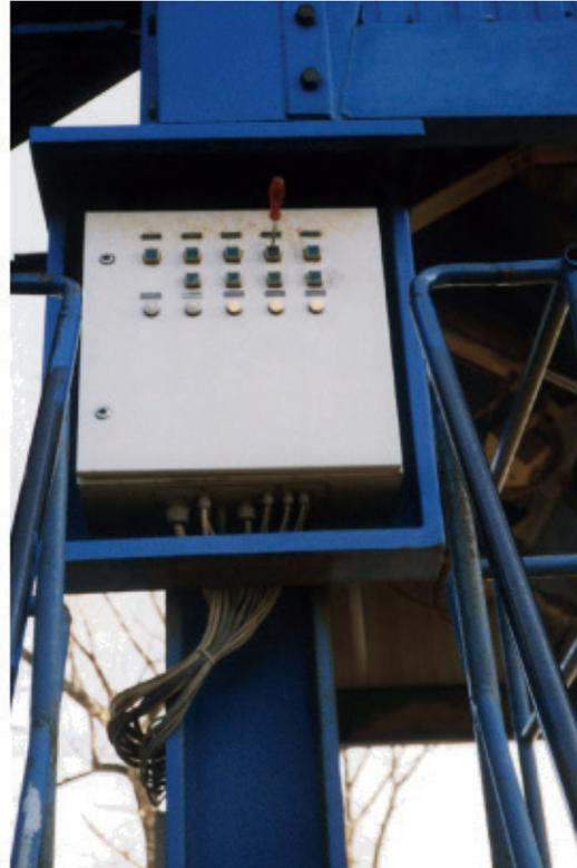
▲ Statt die Siloklappe mit einem Sicherungsseil gegen Schließen zu sichern und dann den Hauptschalter auszuschalten, blockierte er den Schalter mit einem Schraubenzieher in der Stellung „Öffnen“!
