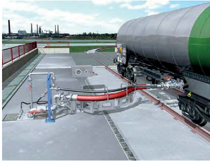
Abbildung 13a: Verlegen von Schlauchleitungen – Schlauchgelenkarm
