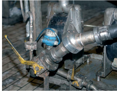
Abbildung 13b: Verlegen von Schlauchleitungen – Kugeldrehgelenk
