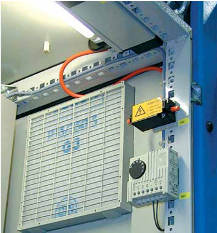
Abbildung 28: Kabel mit orangefarbener Ummantelung für einen Beleuchtungsstromkreis, der nicht vom Hauptschalter getrennt wird
