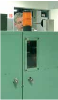
Abbildung 8: Nachträglich eingebautes Sichtfenster in einem Gehäuse für Antriebselemente
