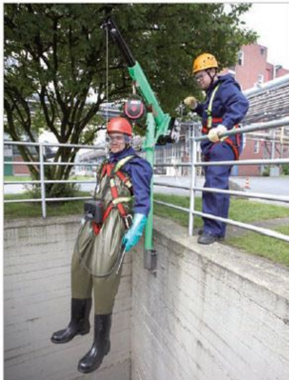
Abbildung 32: Einfahren in eine Abwassergrube
