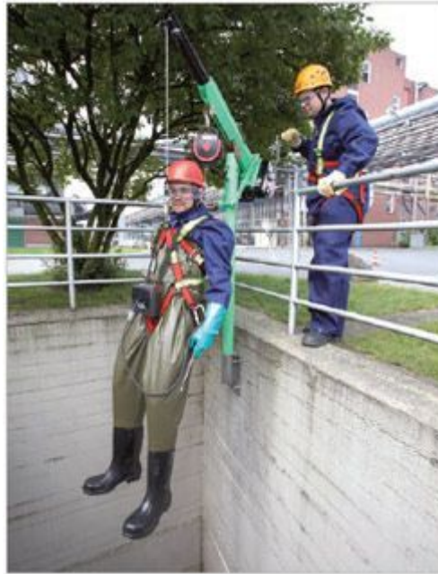
Abbildung 17: Einfahren in eine Abwassergrube
