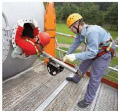
Abbildungen 21: Seiteneinstieg mittels Rettungsrutsche
