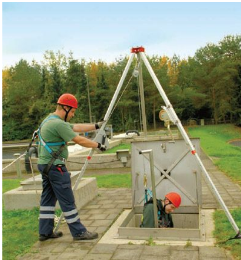
Abbildung 31: Rettung aus einem Schacht
