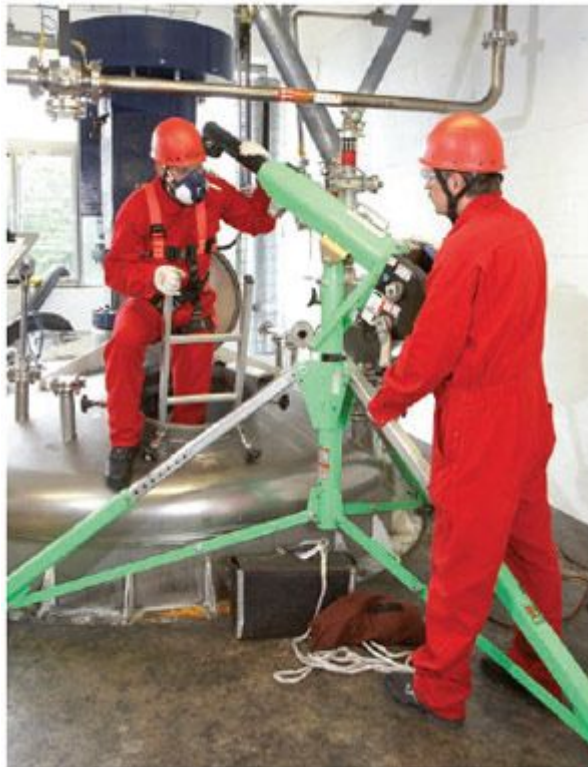
Abbildung 15: Einsteigen in einen Rührbehälter
