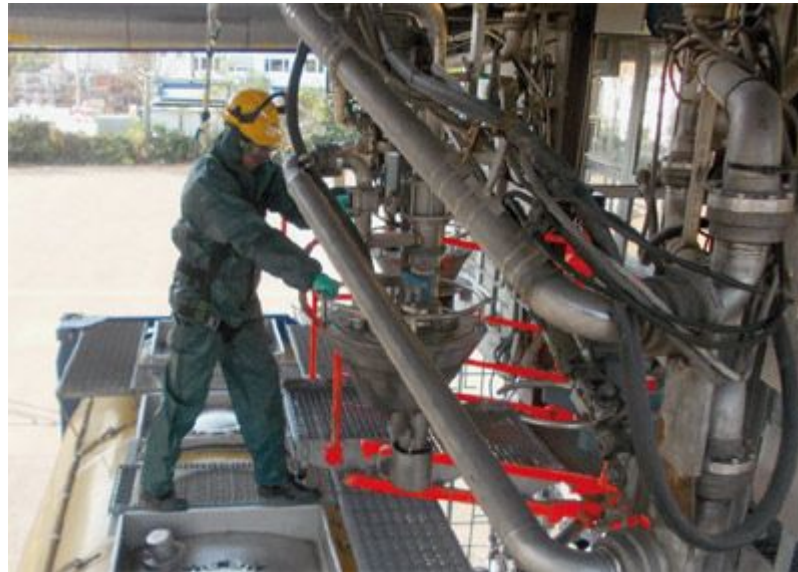
Abbildung 28: Arbeiten mit Absturzsicherung
