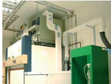
Abbildung 22: Abzug mit aufgesetztem Wäscher
