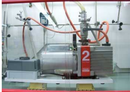
Abbildung 9: Aufgebockte Vakuumpumpe, Luft kann zwischen Arbeitsfläche und Gerät hindurchstreichen
