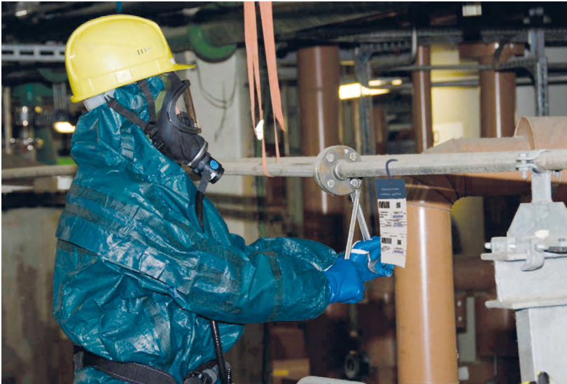
Abbildung 20: Schutz der Rohrleitung vor Wegschnellen
