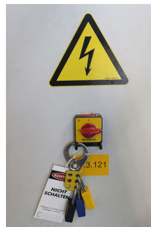
Abbildung 7: Abschließbares Lockout/Tagout-Element mit persönlichen Schlössern
