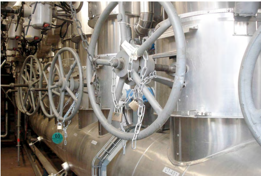
Abbildung 21: Gesichertes Handrad
