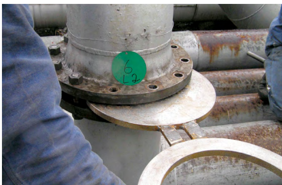
Abbildung 23: Brillensteckscheibe
