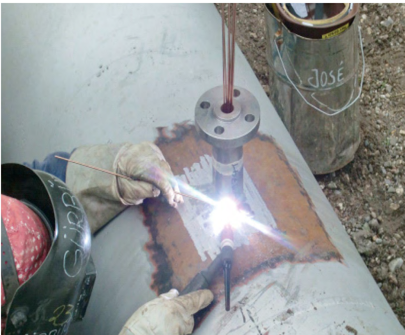
Abbildung 35: Aufschweißen eines Stutzens auf eine produktführende Rohrleitung
