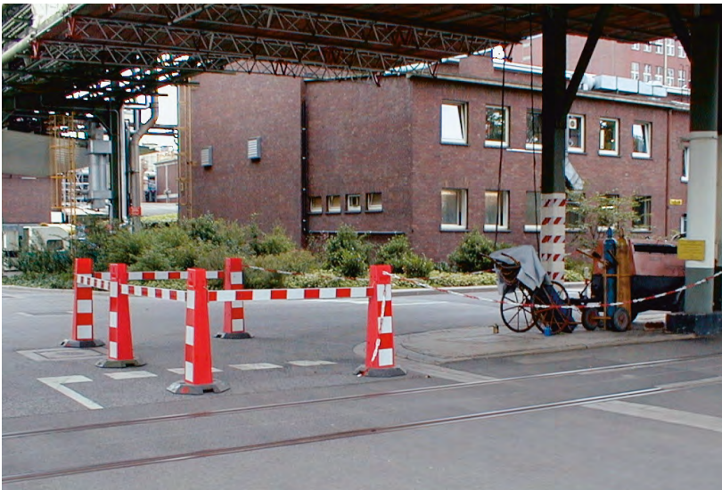
Abbildung 16: Absicherung bei Montagearbeiten
