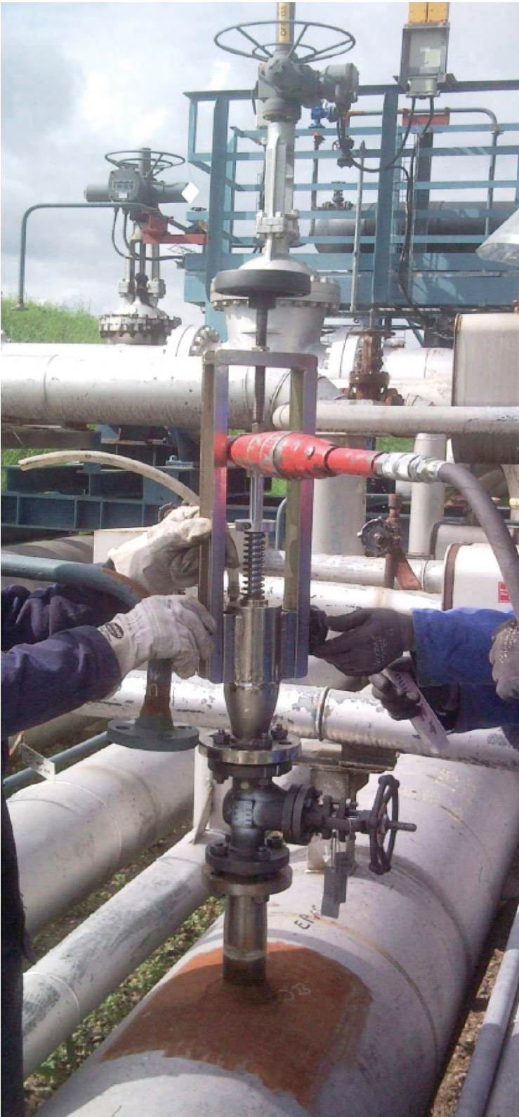
Abbildung 36 : Anbohren des produktführenden Leitungsstücks
