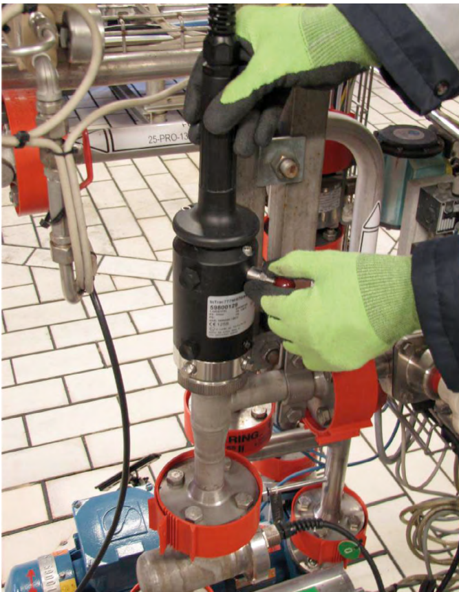
Abbildung 33: Schleusen/Wechselarmatur
