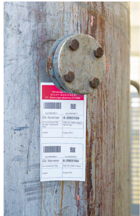
Abbildung 26: Blindflansch mit Tag
