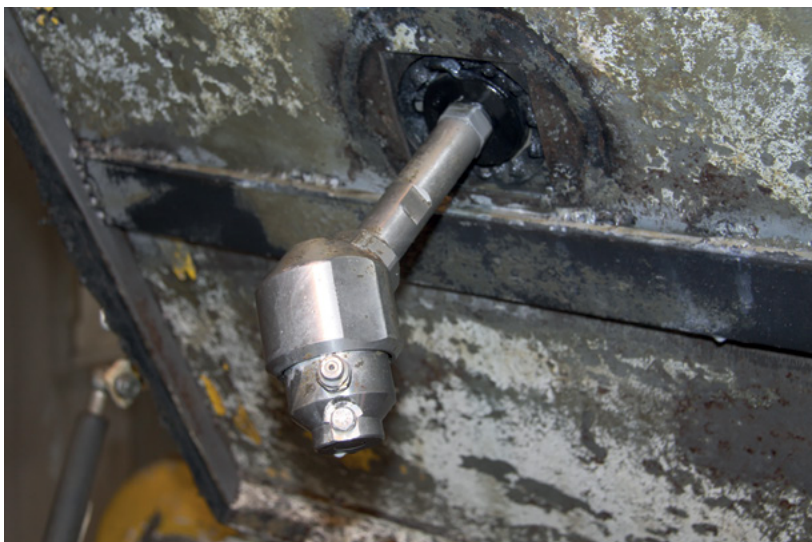
Abbildung 34: Hochdruckreinigungsdüsen im Inneren des Betonmischers
