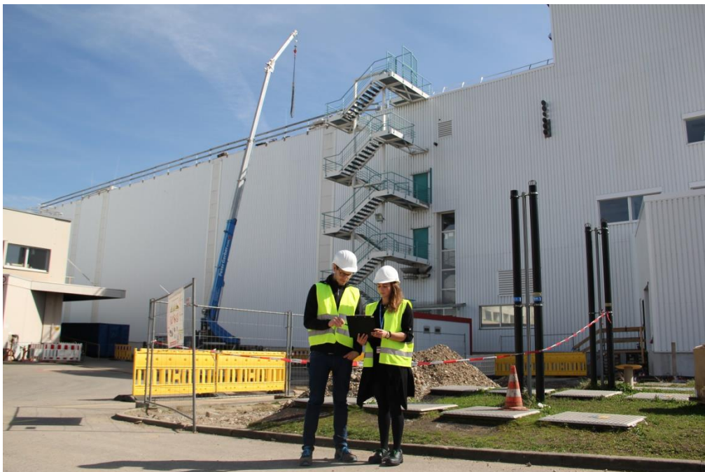
Abbildung 3: PASsT-Mitglied und EHS-Mitarbeiter bei einer Baustellenbegehung
