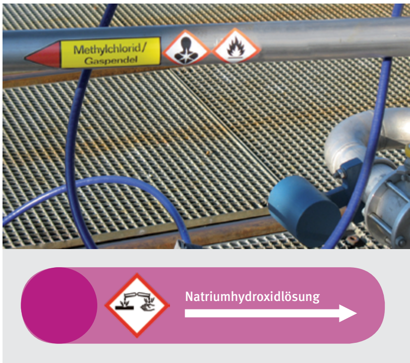
①⑤ Abbildung 11: Innerbetriebliche Kennzeichnung von Rohrleitungen gemäß ASR A1.3 und TRGS 201
