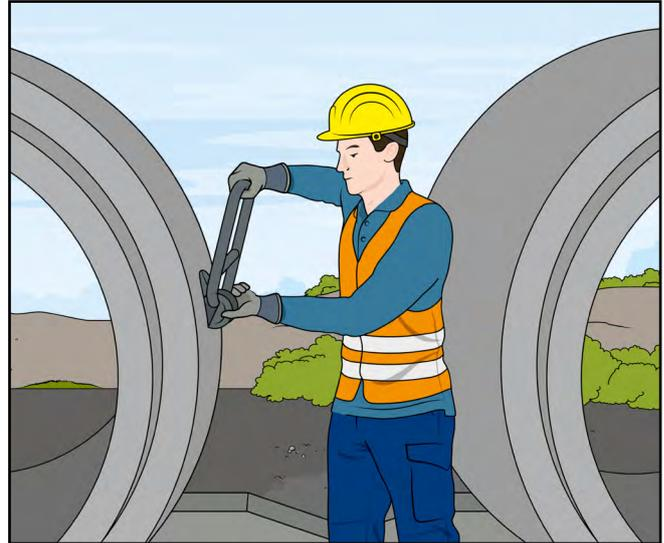
Achten Sie auf ausreichende Abstände ( $>0,5\text{ m}$ ) zwischen den Betonfertigteilen für ein sicheres Anschlagen.
