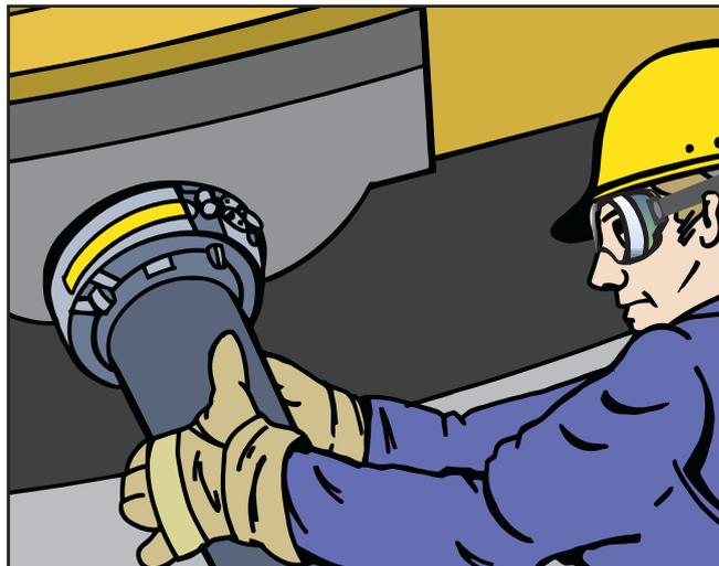
Mit der Schlauchschelle ist die Kupplung gegen Lösen zu sichern.
