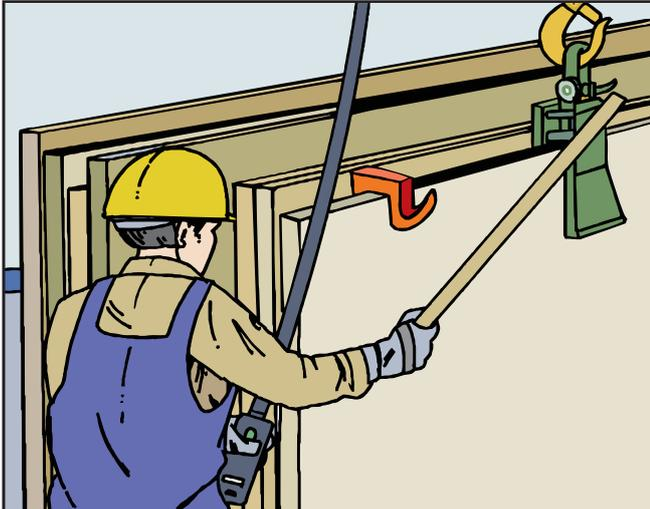
Halten Sie sich niemals im möglichen Kippbereich von Unmaßtafeln auf. Verwenden Sie einhängbare Keile. Positionieren und lösen Sie Zangen oder Hebebänder mit Hilfsmitteln.
